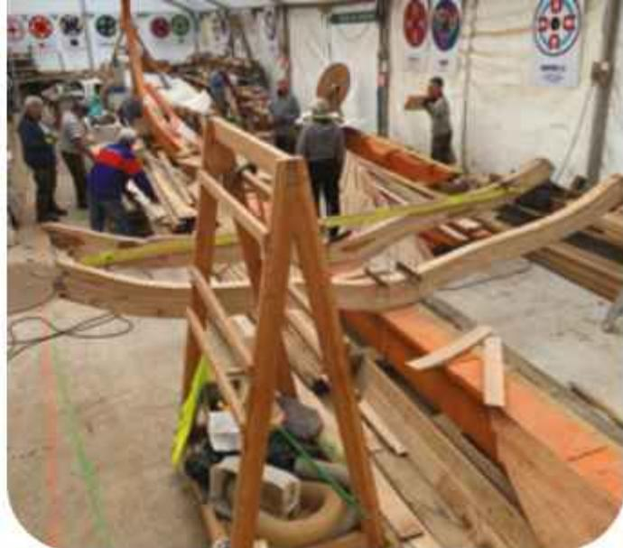
La vergue, la partie qui permet de lever la voile le long du mât, est aussi terminée, comme le mât. A la mi-décembre, la coque va donc commencer à monter sur 16 niveaux jusqu'en mars, période où le navire sera prêt pour la mise à l'eau au Port des Sables d'Olonne.
